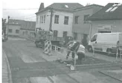
Ulice Bosonožské náměstí, budování větších odvodňovacích žlabů.
