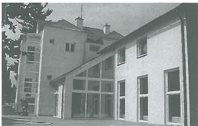
Pohled na dokončenou zadní část objektu s recepcí a pohybovými prostory.
